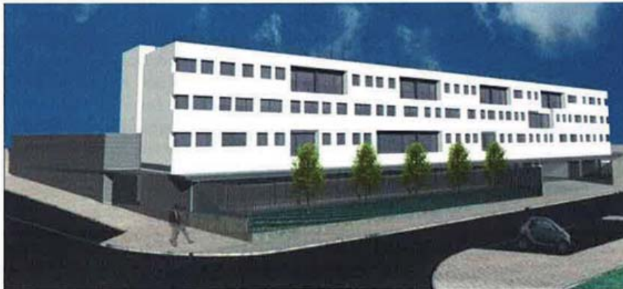
Bairro Padre Cruz - Residências Assistidas e Creche
