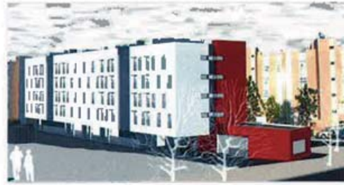
Alto da Faia IV - Lote A
