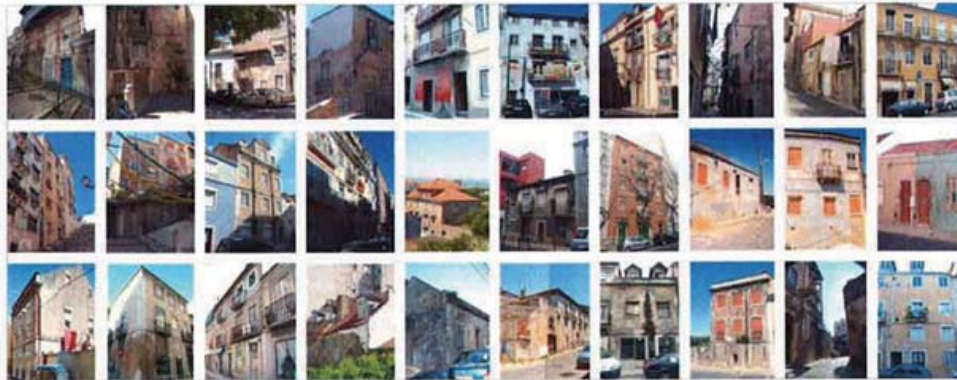
Edifícios do Programa Lisboa a Cores
