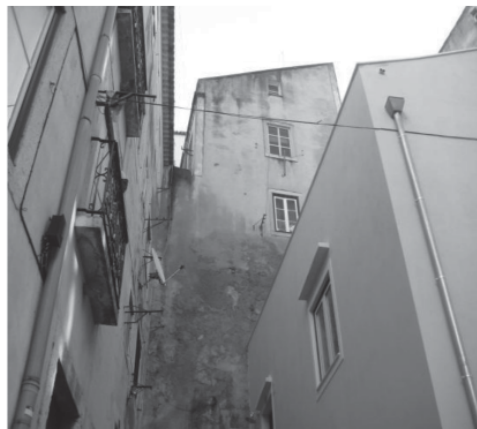
Imagem 10 - Vista Parcial da Fachada Lateral
