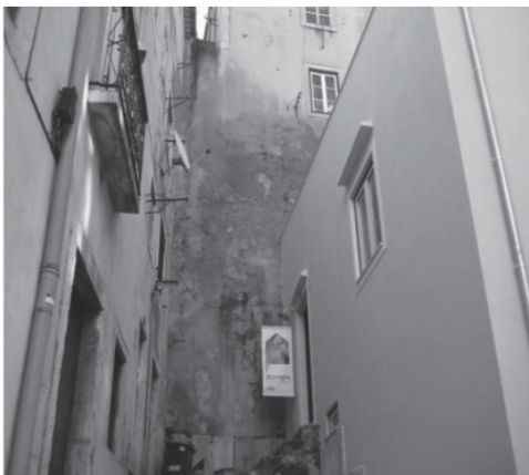
Imagem 9 - Vista Parcial da Fachada Lateral
