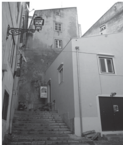
Imagem 4 - Vista da Fachada Lateral do Imóvel para o Beco do Rosendo
