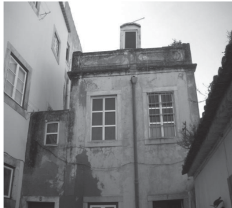
Imagem 8 - Vista da Fachada Principal do 1º Andar e Águas Furtadas
