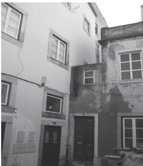
Imagem 1 – Vista da Entrada do nº6 do Largo dos Trigueiros e edifício adjacente
